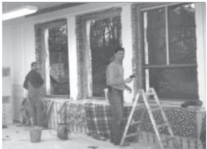
Andreas Franz und Lars Schönjahn beim Einbau der Fenster
