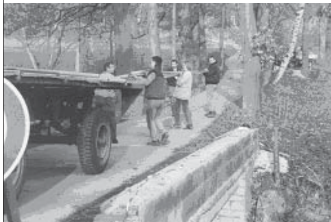
Montieren der Brückengeländer 17. Nov 05
