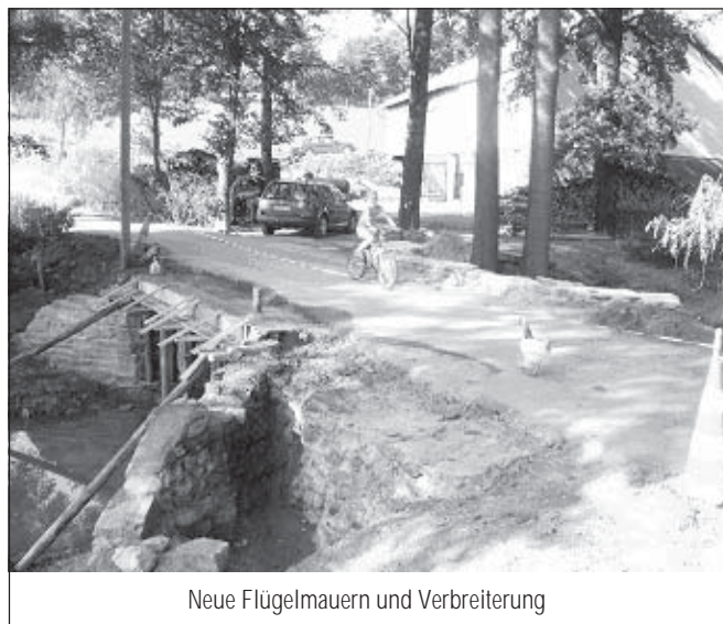
Vorbereitung der Brückenverbreiterung
