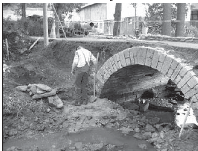
Vorbereitung der Brückenverbreiterung
